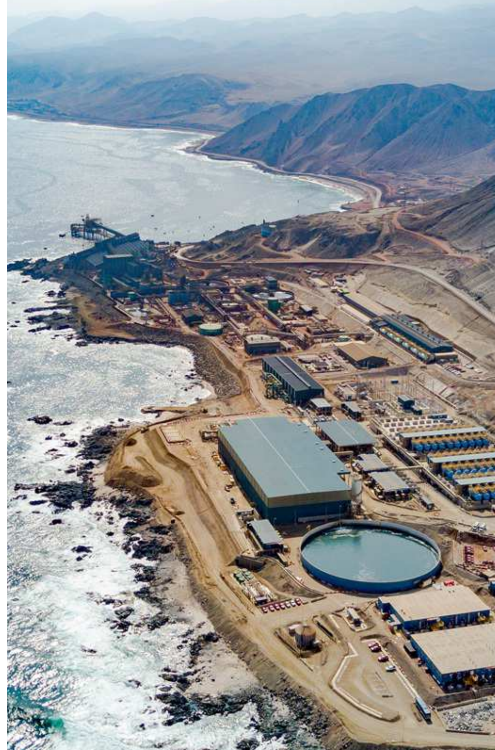
Planta desalinizadora Escondida Water Supply (EWS)
